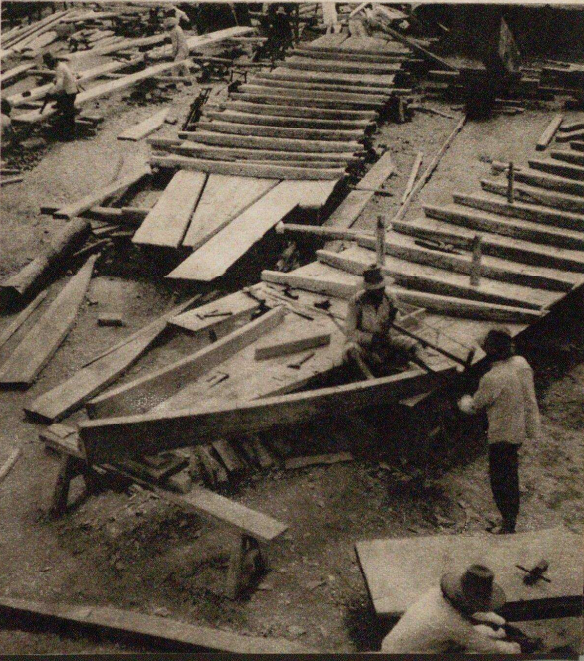
華北交通の便用す新製船の造船作業——山東省史各莊造船所にて
