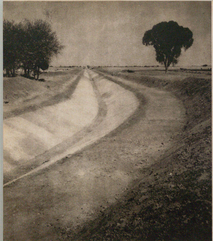
新設された灌漑溝
